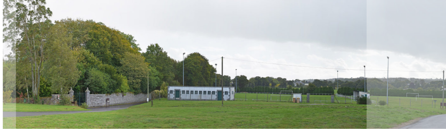
Etat Initial (panoramique sur 80° de champ latéral - recadrage sur 60°)
